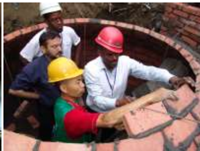
国际学员实践沼气池建设
