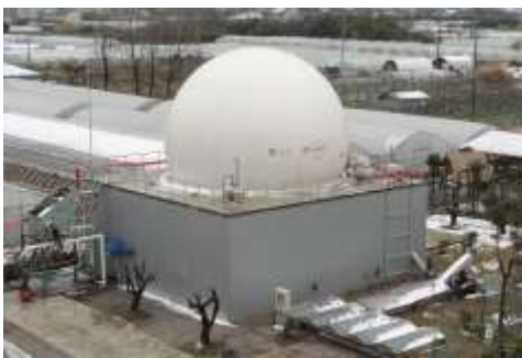
牛粪干发酵实验装置
