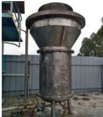
20M 3 反应器已用于四川眉山某养猪场100t/d污水处理
